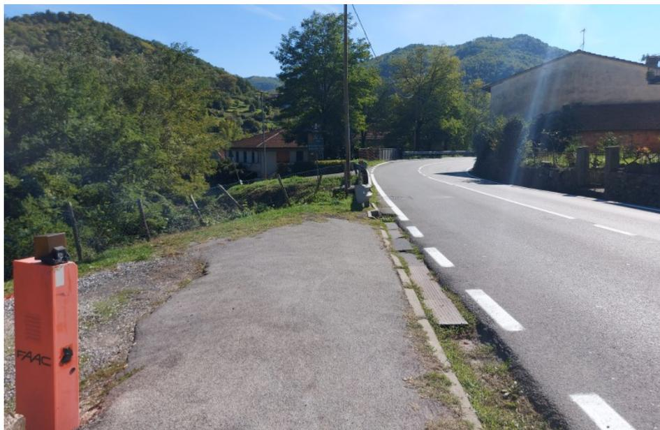
In questo tratto, che si sviluppa dal km 57+287 al km 57+315 circa, è previsto, oltre al rifacimento del marciapiede prospiciente il passo carrabile, la realizzazione di un muro di sostegno che consenta l'ampliamento della pertinenza stradale per il completamento del percorso pedonale fino all'area di parcheggio presente nella viabilità verso valle.
